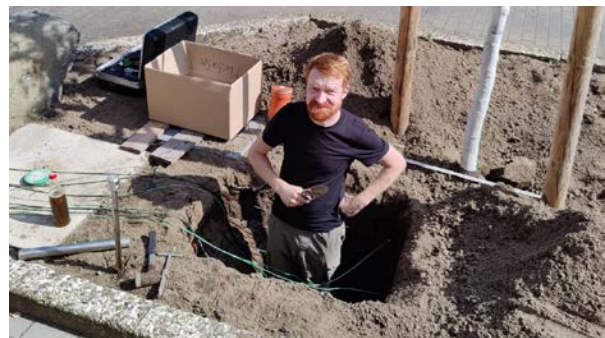
Einbau von Sensoren zur Bodenwasserhaushaltsmessung in eine Pilot-Baumgrube.
