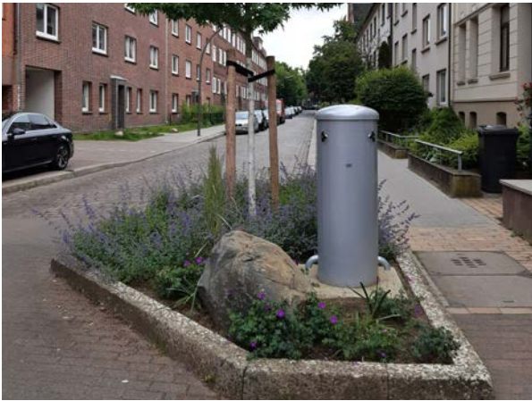
Fertiggestellte Pilot-Baumgrube in der Wöllmerstraße in Hamburg-Harburg.
