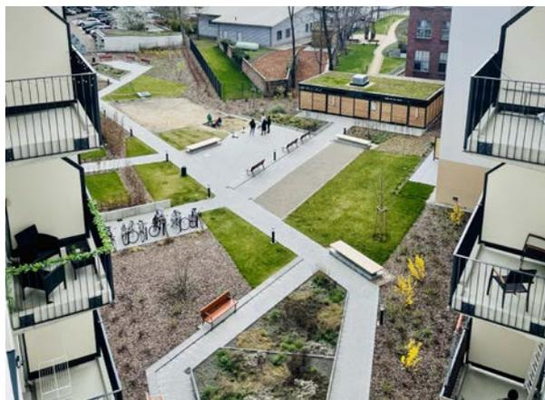
Systemaufbau Retentions-Gründach im Hinterhof auf einer Tiefgarage, welcher im Falle von Starkregen große Wassermengen speichern und so benötigtes Bewässerungswasser bereitstellen kann.
