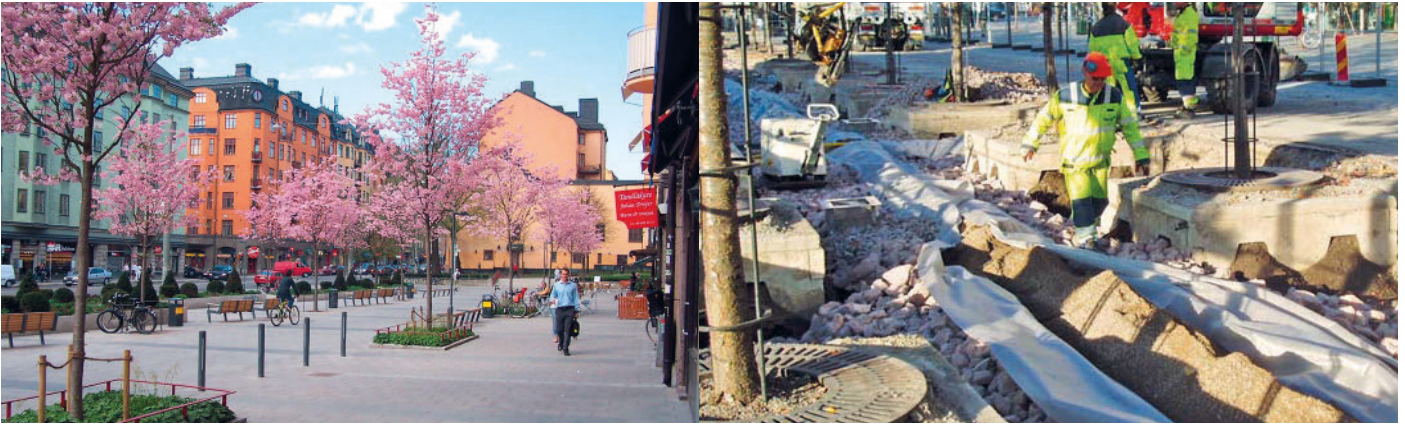
Platzsanierung mithilfe von Tree Pits, Quelle: Embrén et al. 2008
