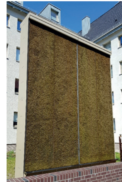
Abbildung: Mooswand als Fassadengestaltungselement mit integriertem Bewässerungssystem zum Funktionserhalt (Bild: TransMiT/ISAH)
