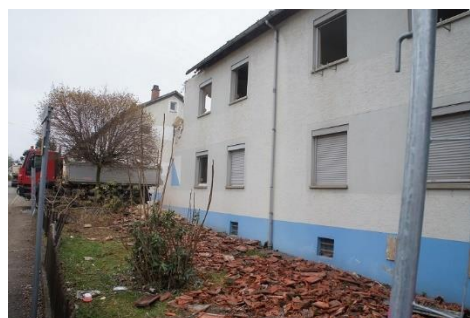
Abb. 5.13: Gipskarton und Dachziegel vor Rückbau separiert (Quelle: ifeu Heidelberg).
