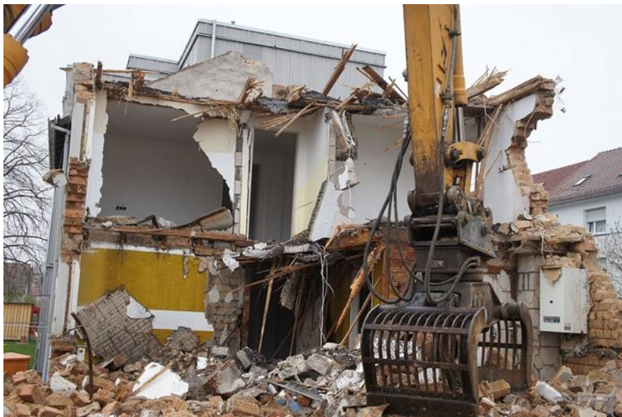
Abb. 5.20: Abbruch und Verladung mittels Sieblöffel (Quelle: ifeu Heidelberg).
