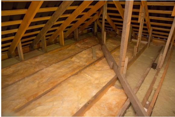
Abb. 5.8: Lose verlegte Dachbodendämmung bzw. auf Umkehrdach (Quellen: ©Елена Трыфанова-AdobeStock.com (links), ©Austrotherm/FPX (rechts)).
