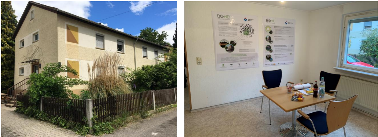
Abb. 4.2: Bolzstraße 9 wird zu BOHEI-Treff (Quelle: Sippel | Buff).
