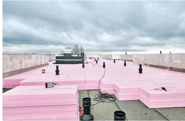
Abb. 5.8: Lose verlegte Dachbodendämmung bzw. auf Umkehrdach (Quellen: ©Елена Трыфанова-AdobeStock.com (links), ©Austrotherm/FPX (rechts)).
