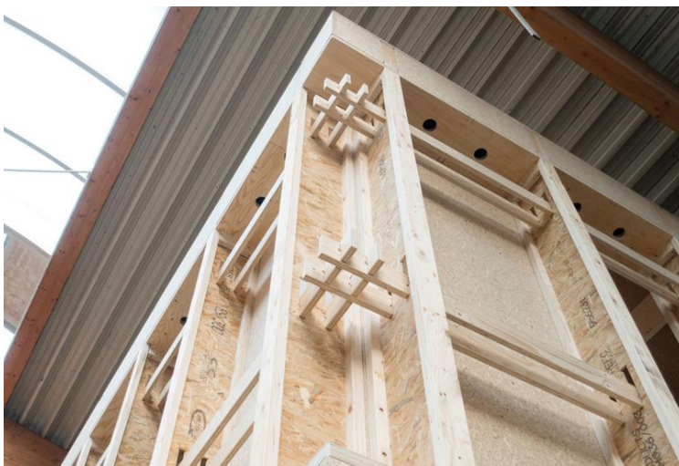
Abb. 5.9: Holzbau mittels Steckverbindung (Quelle: STELLINNOVATION GmbH).
