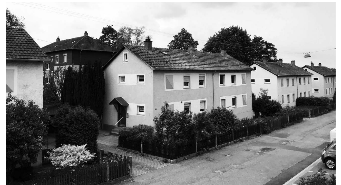
Bolzstraße mit Bestandsgebäude
