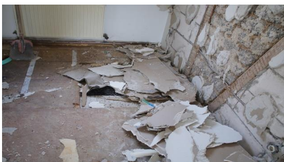
Abb. 5.13: Gipskarton und Dachziegel vor Rückbau separiert (Quelle: ifeu Heidelberg).
