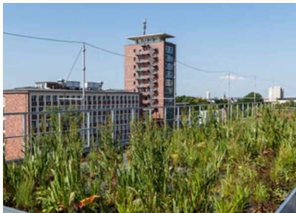
Gründach – Beispiel für multifunktionale blau-grüne Infrastruktur: Energieversorgung, Wasserrückhaltung, Wasserspeicherung, Verdunstung
