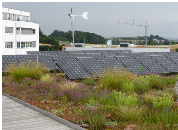
Gründach – Beispiel für multifunktionale blau-grüne Infrastruktur: Energieversorgung, Wasserrückhaltung, Wasserspeicherung, Verdunstung
